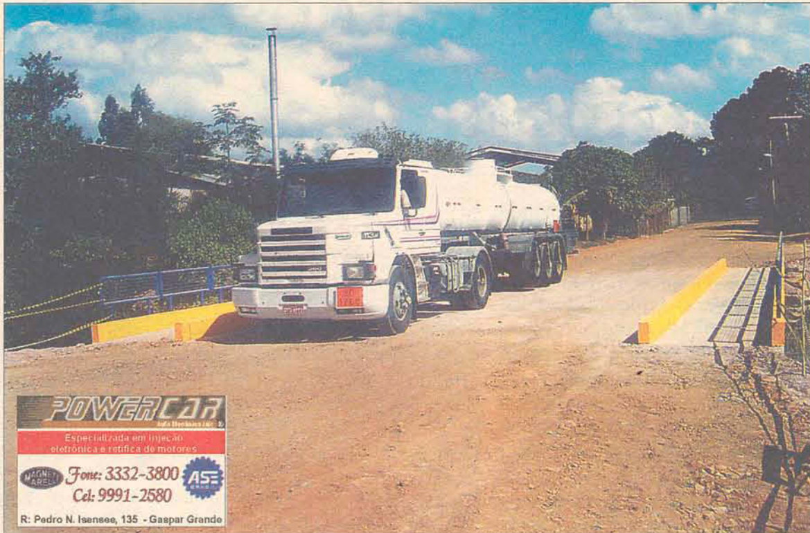
Agora a comunidade aguarda pelo asfaltamento da rua Vida Flávio Dias, que deve sair em breve
