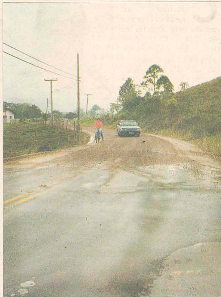
Estrada Geral do Lagoa: apenas parte pavimentada
