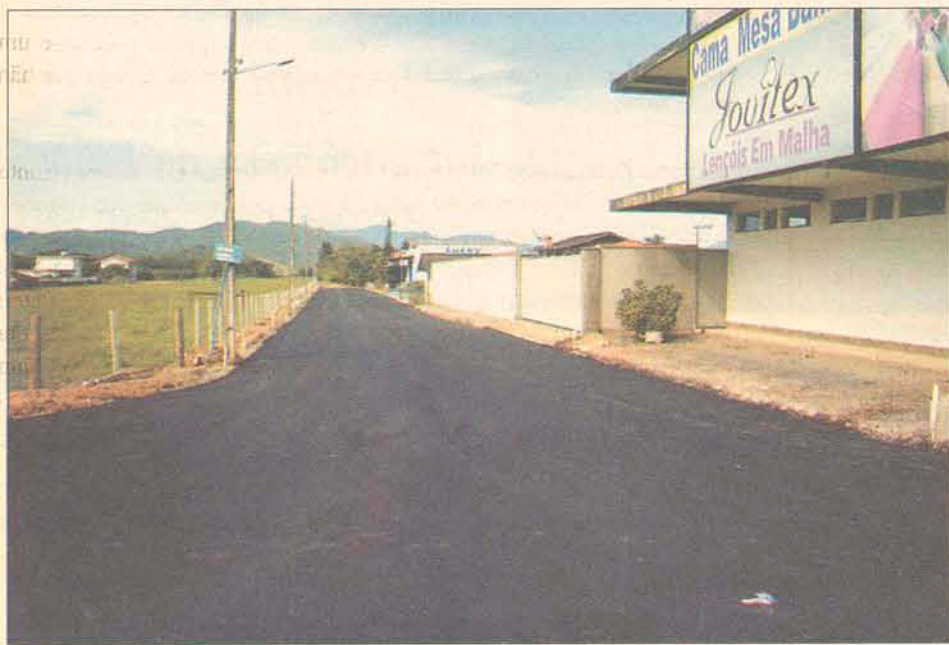
Rua Oswaldo Matias Schmitt, no Poço Grande, recebeu asfalto no início de abril
