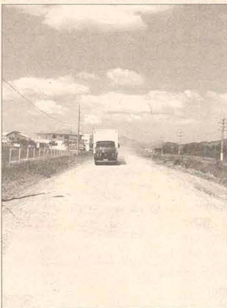
Julio Schramm receberá pavimentação
