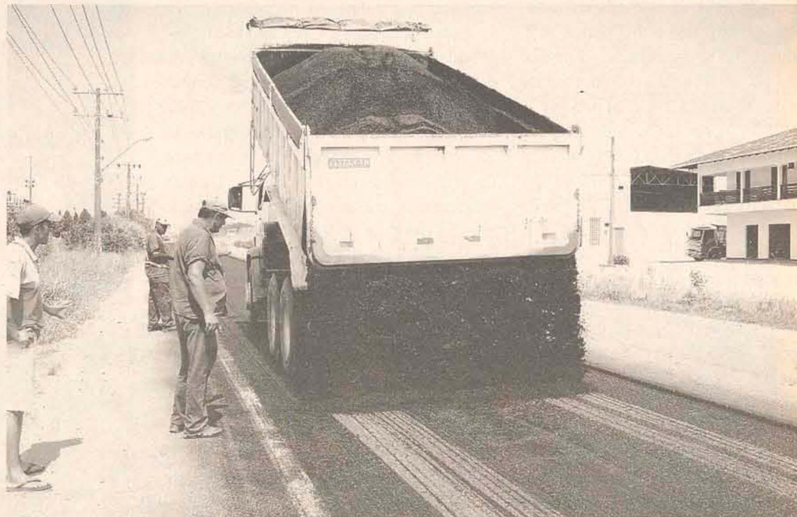
Asfaltamento da Francisco Mastella foi concluído no sábado, dia 4
