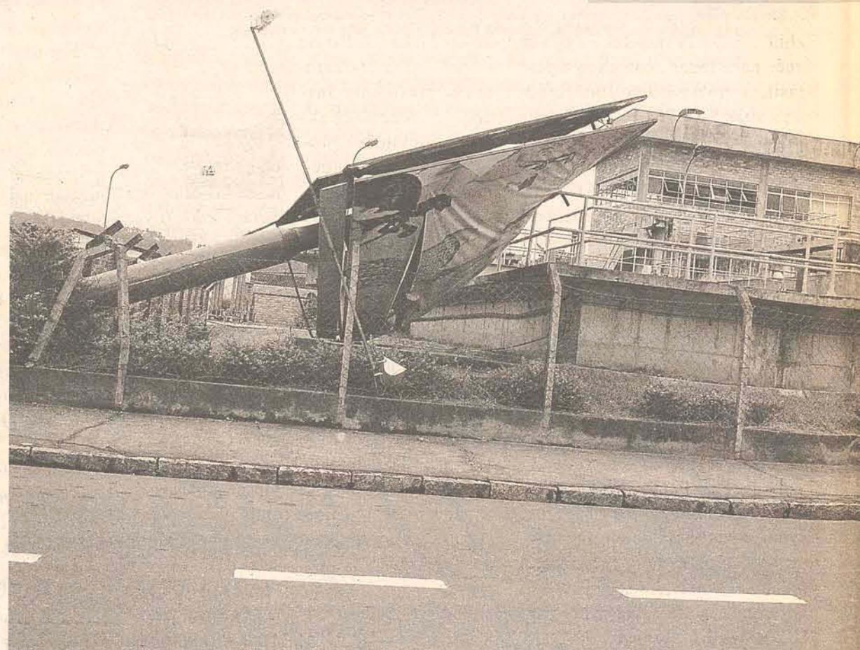
Força do vento arrancou placas município.
