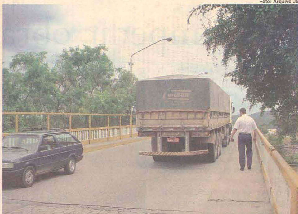
Ponte está com estrutura abalada e apresenta riscos à população
