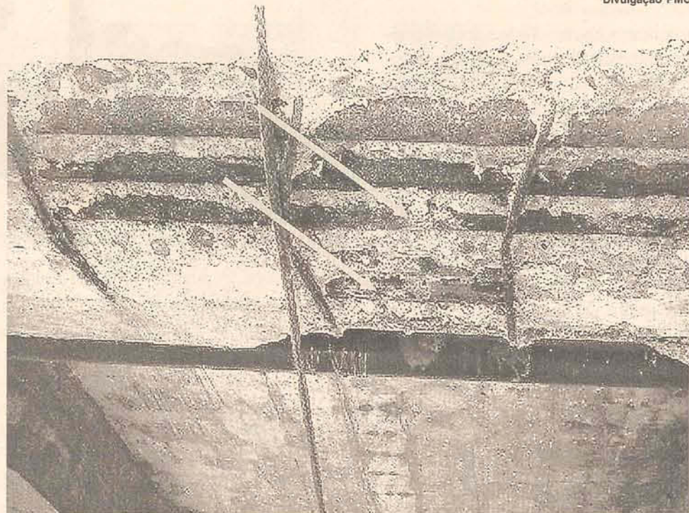
Barras de ferros expostas apresentam corrosão que compromete a estrutura
