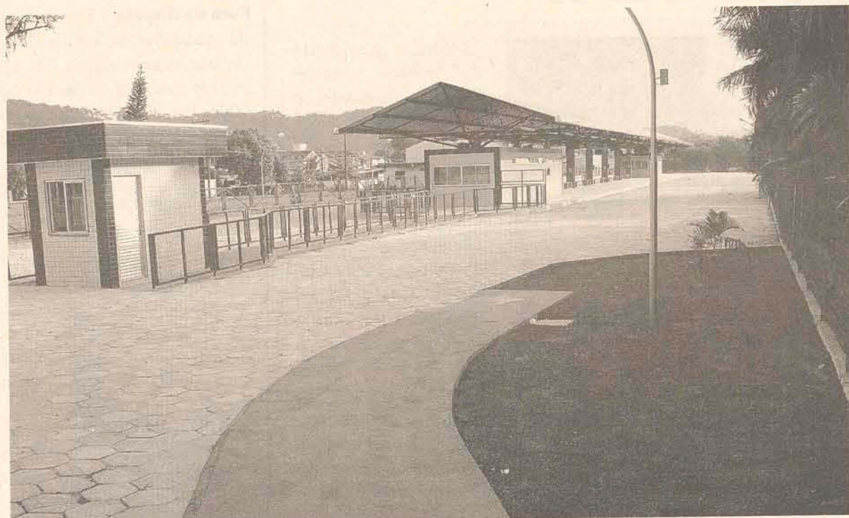
Obra custou aproximadamente R$ 850 mil
