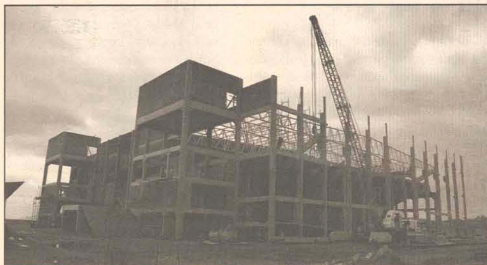
*Construção da Arena Multiuso de São José.
