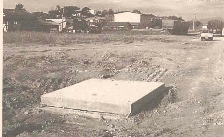
Foram instalados mais de 600 tubos para resolver os alagamentos
