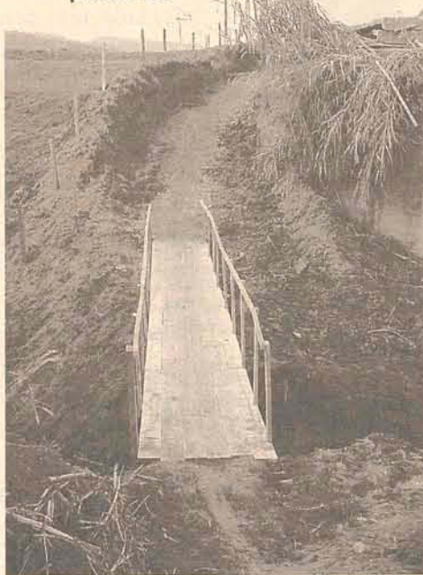
Passarela é de uso restrito dos pedestres
