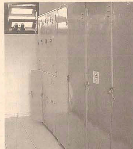
A sala que deveria armazenar os equipamentos dos bombeiros virou vestiário, mas o ideal é que houvesse cabides e bancos
