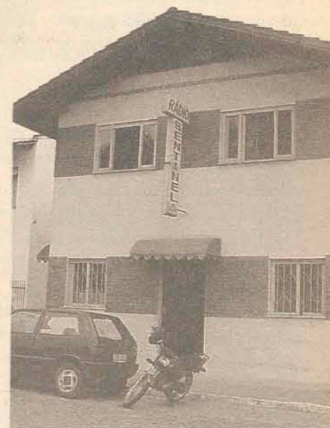
A Sentinel opera com 2500watts de potência
