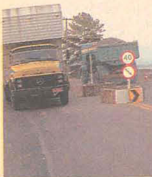
Ilha de segurança já está em construção na Ivo Silveira. Pág:11-A
