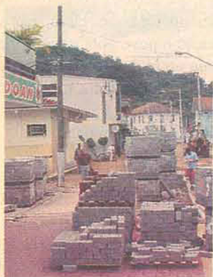
Reurbanização da rua Coronel Aristiliano Ramos já está na última fase.
