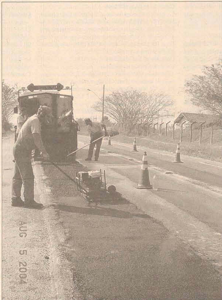
Após longa espera, finalmente a Avenida está sendo recuperada
