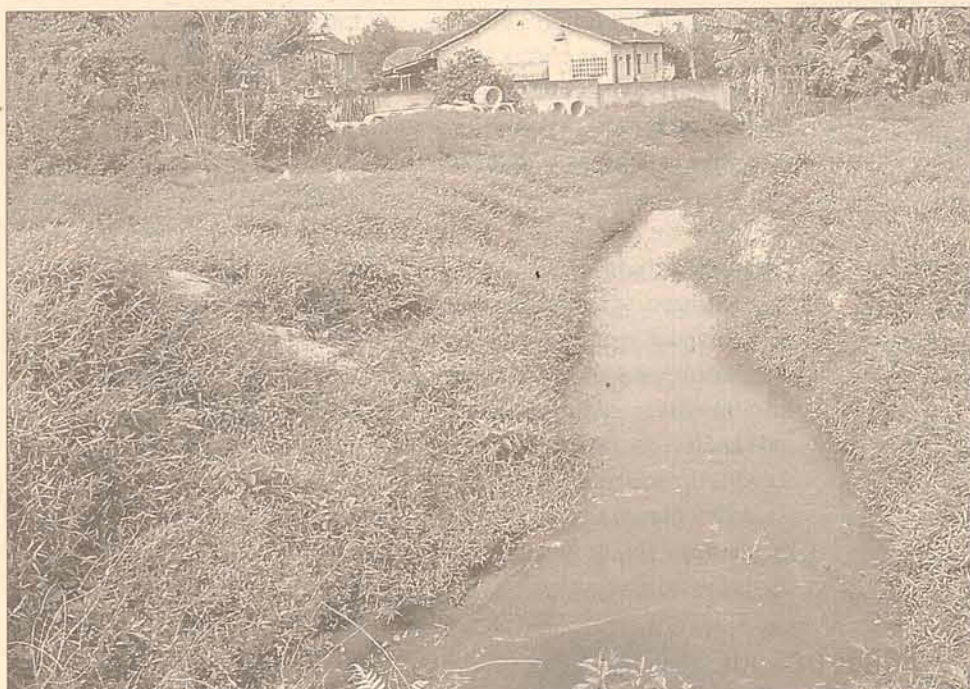
Esgoto a céu aberto preocupa moradores
