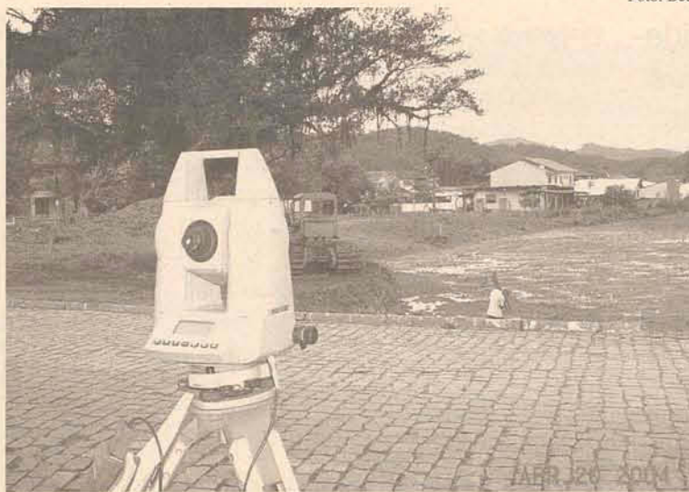
Obra civil tem início previsto para o mês de junho
