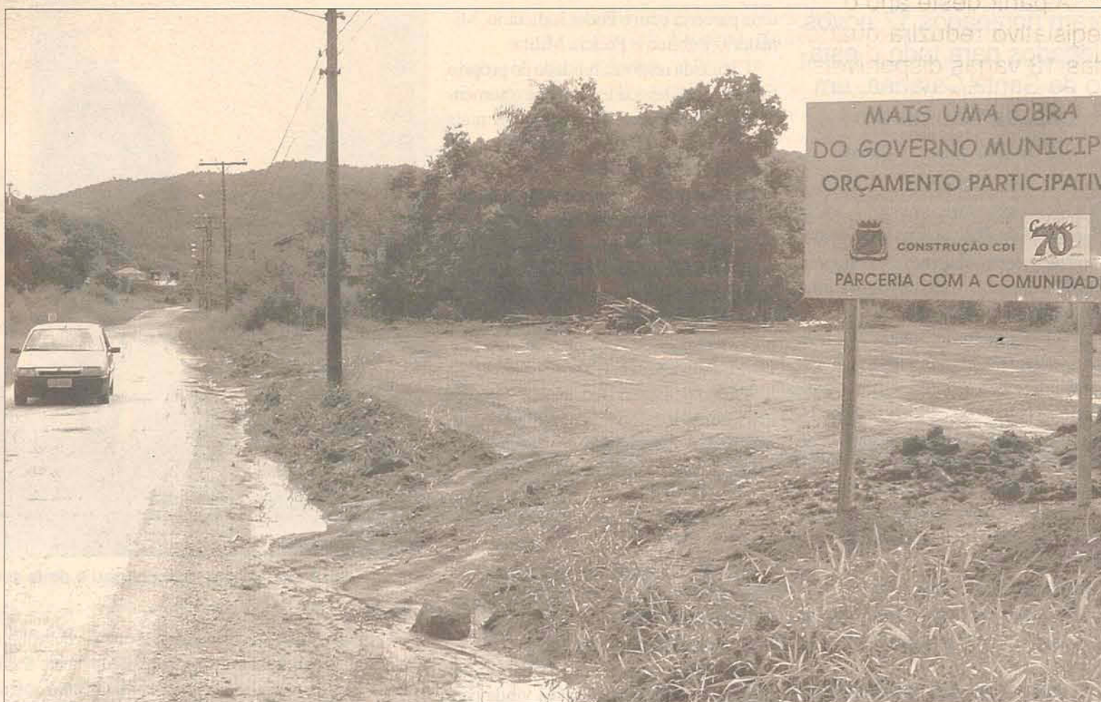
Área para construção do CDI já está pronta, falta apenas a câmara aprovar a dotação
