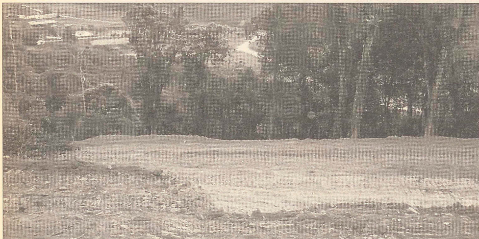
Local onde será construído o reservatório de água no bairro Macuco
