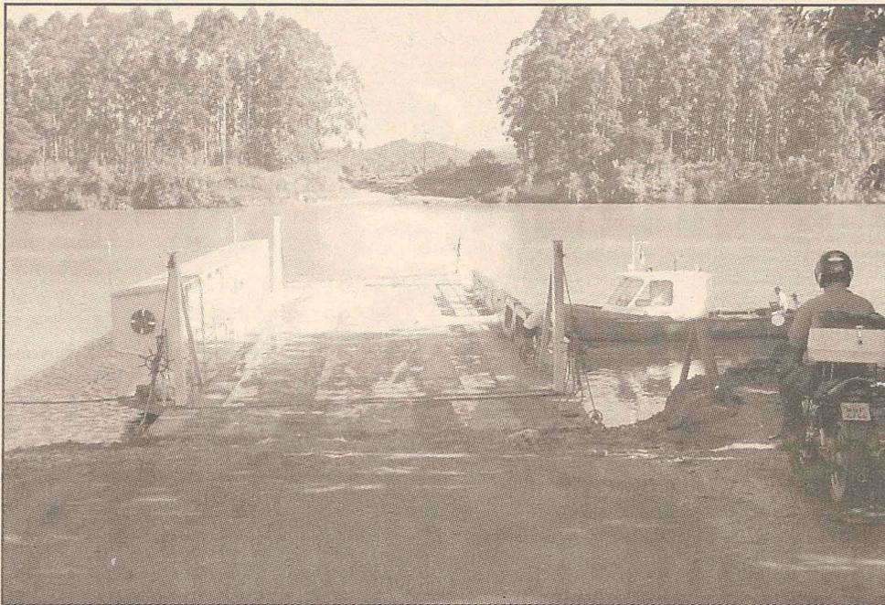
Apesar dos revestimentos com macadame nas encostas onde a balsa atraca é visível o abarrotamento causado nas margens. O projeto, que será apresentado nas próximas semanas, provavelmente terá um atracadouro de concreto com barras de ferro por onde a balsa deslizará. A idéia inicial, também prevê a reurbanização das entrada para a embarcação.
