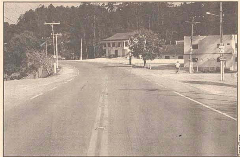
Lombada eletrônica deverá ser instalada próximo a ponte do Bateias. a definição para começar o ginásio, que custará R$ 250 mil. Para resolver o problema do saneamento, a diretora diz que foi encaminhado um outro projeto, desta vez para o BNDES, Banco Nacional de Desenvolvimento Econômico e Social. Luciane explica que este financiamento servirá para solucionar o problema de saneamento daquela região.
