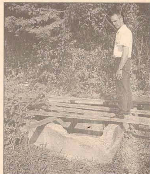
A comporta está localizada as margens da Rodovia Jorge Lacerda
