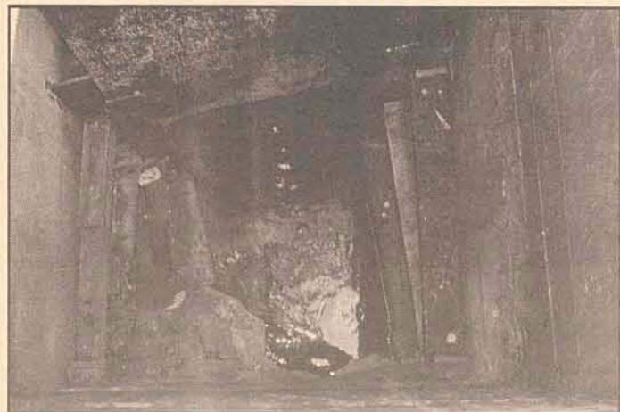
Comporta provisória construída pela comunidade
