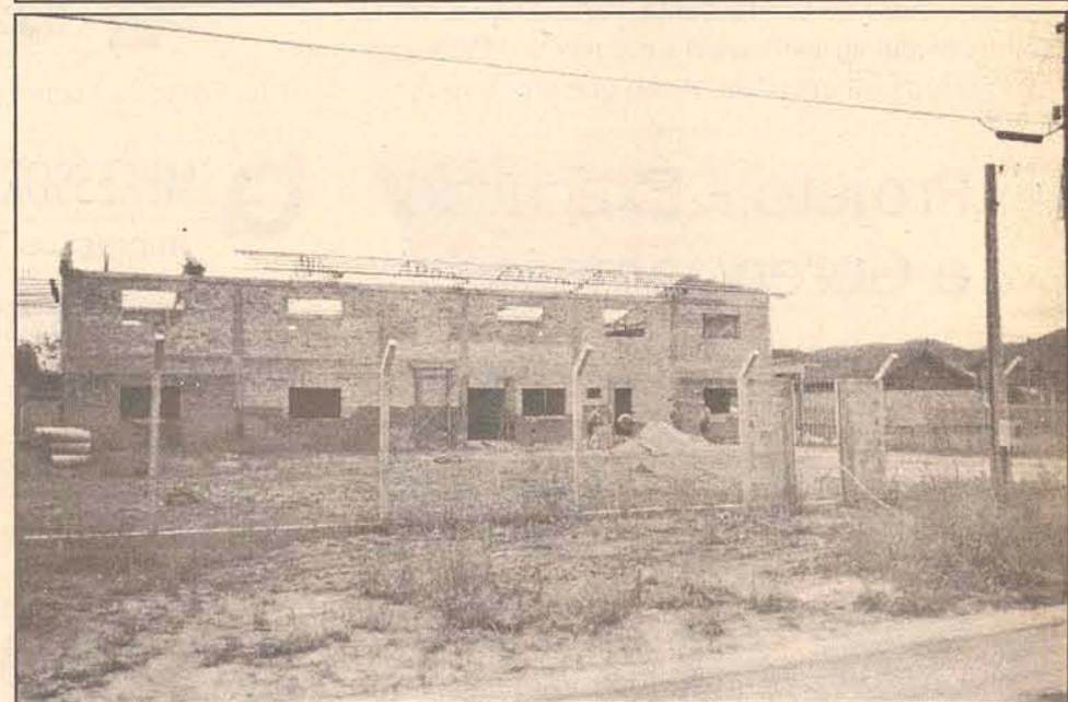
Fase de colocação do telhado
