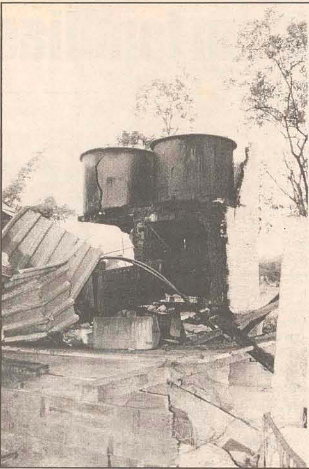
50m2 ficaram destruídos com a explosão
