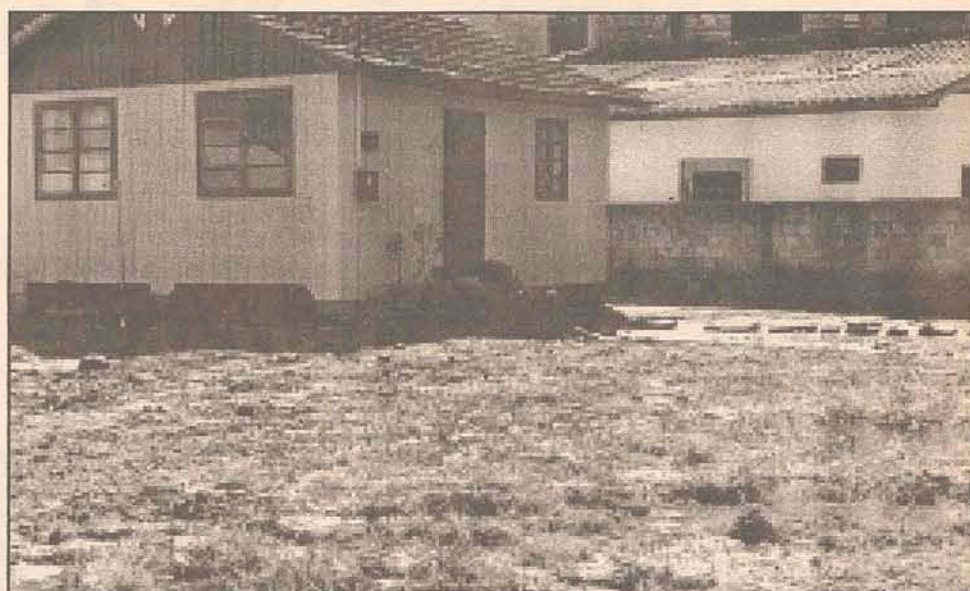
Situação das ruas após as chuvas
