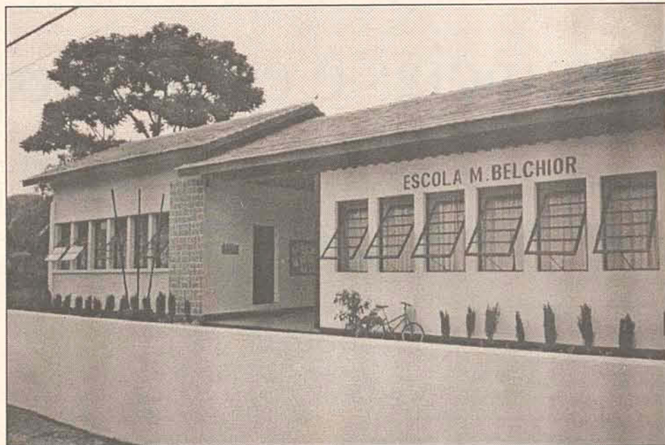
Escola no Belchior passa por reforma total
