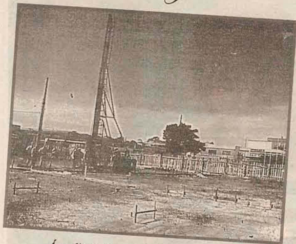
Área livre aparecendo o estaqueamento para construção do Tordesilhas.
