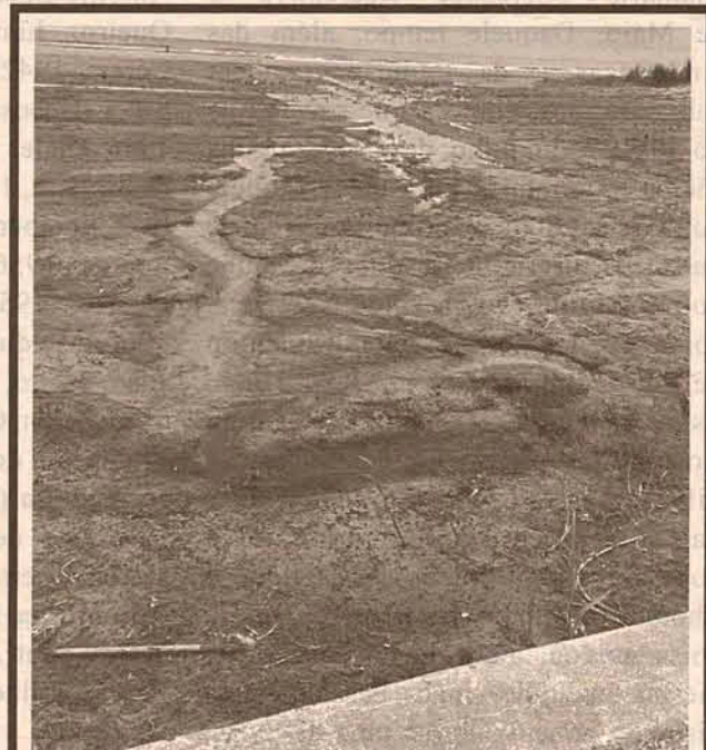
Ligações clandestinas no esgoto pluvial, desembocando na praia do Mar Grosso, como o da foto, continuam se constituindo em grave problema. Prefeito Candemil promete agir com rigor os infratores, pelo visto, em grande número.
