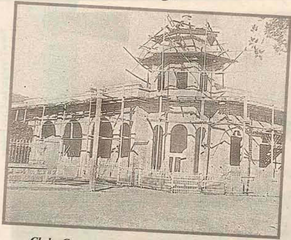
Clube Congresso Lagunense, com a atual sede em construção, em junho de 1935.
