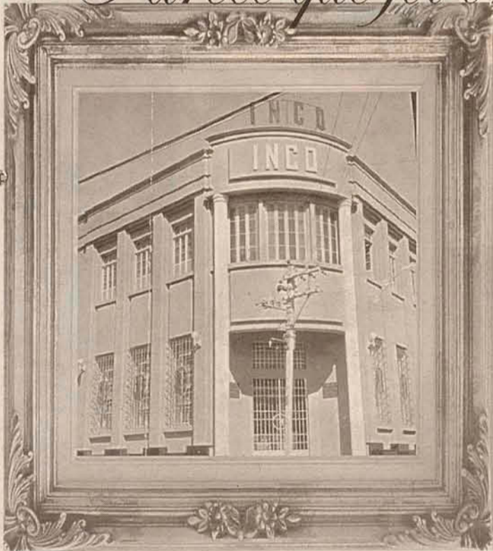
Em uma das esquinas da rua Osvaldo Cabral, na década de 60, então em funcionamento, o Banco Inco. Atualmente, o prédio é de propriedade de uma família lagunense.
