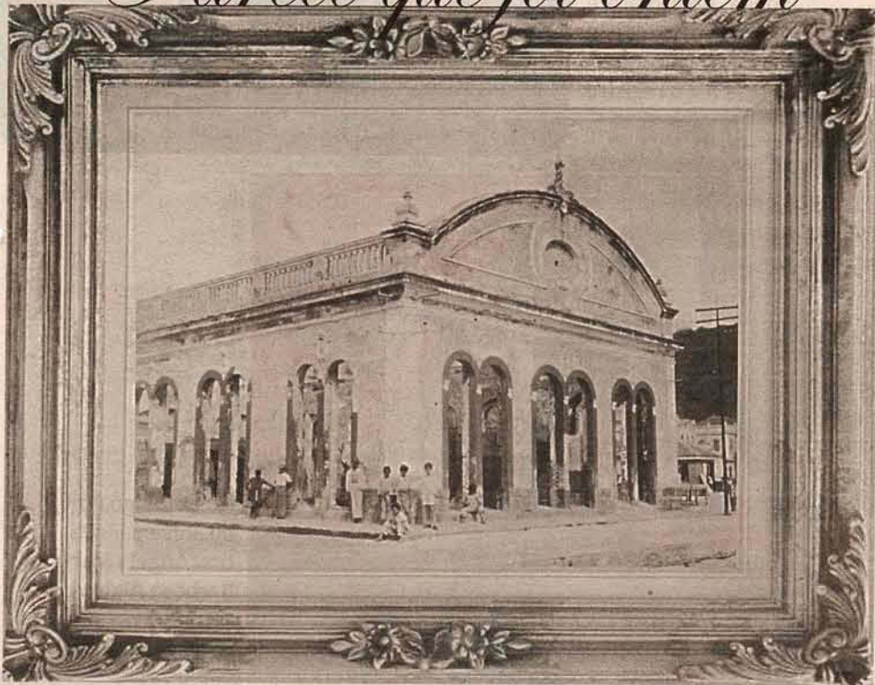
Ruínas do antigo Mercado Municipal de Laguna, após o incêndio em 1937.
