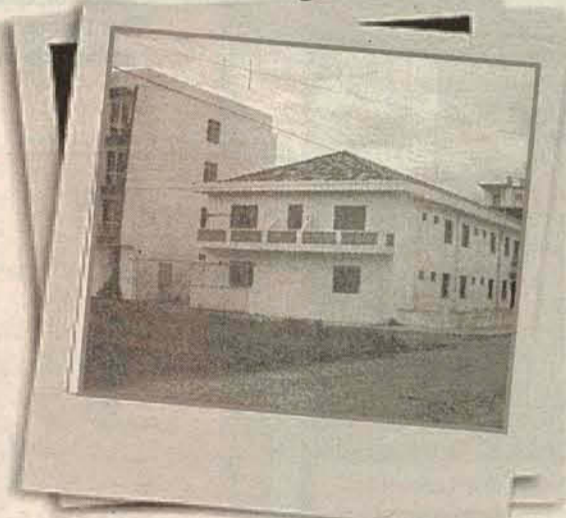
Já aparecendo as novas instalações.
