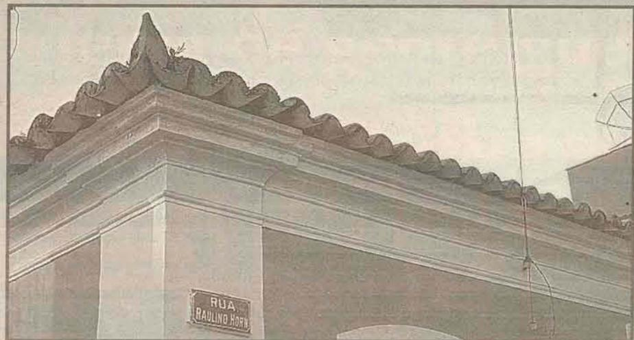
Diz-se de Peito de Pomba àquele arremate no canto externo dos telhados, sobre os cunhais dos edifícios. Consiste em recortar a telha e, habilmente, aplicá-la inclinada em  $\frac{1}{4}$  de círculo, na junta de encontro das águas do telhado. O nome se origina desse círculo de  $\frac{1}{4}$  de volta completa, que possui as características e o perfil do peito da ave.
