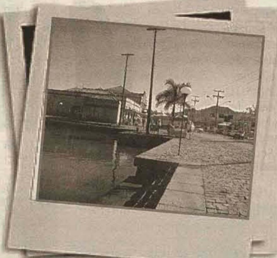
O mesmo local hoje passando por uma reforma e ampliação.
