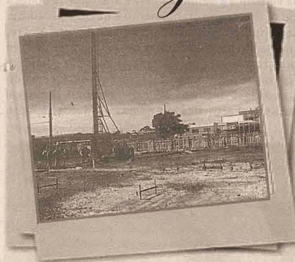
Área livre aparecendo o estacionamento para construção do Tordesilhas, nos anos 90.
