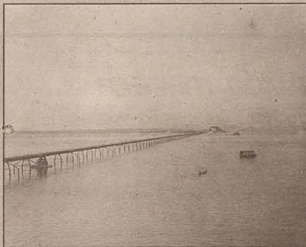
1959 a atual ponte rodoviária, conforme dados fornecidos pelo arquiteto e professor Dagoberto da Silva Martins.
