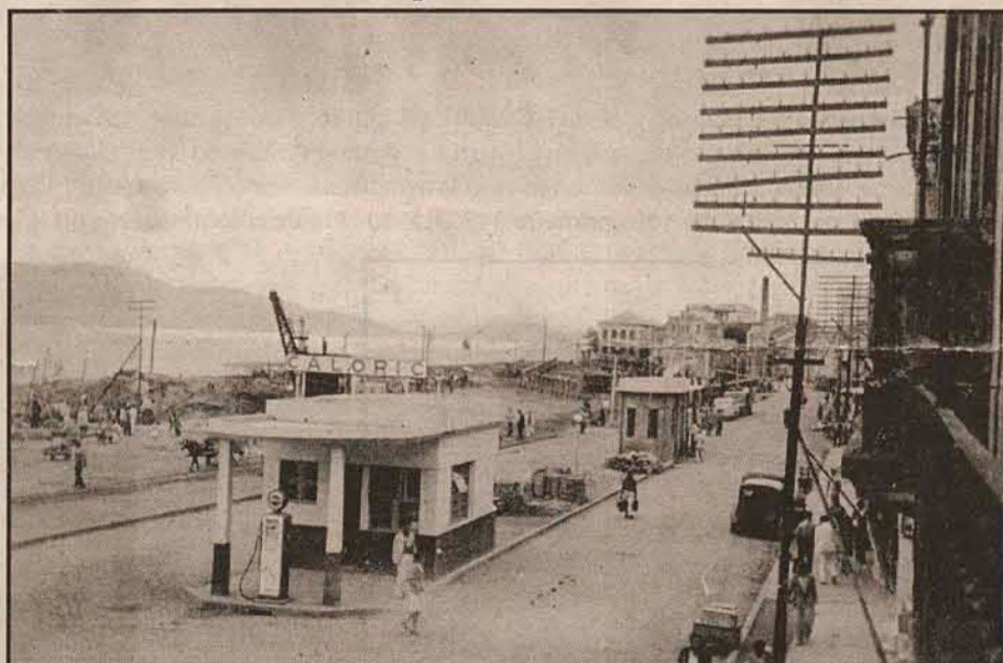
No acervo de Rodrigo Bento, as obras nas docas, em 1946. Em primeiro plano, destaque para dois postos de gasolina.
