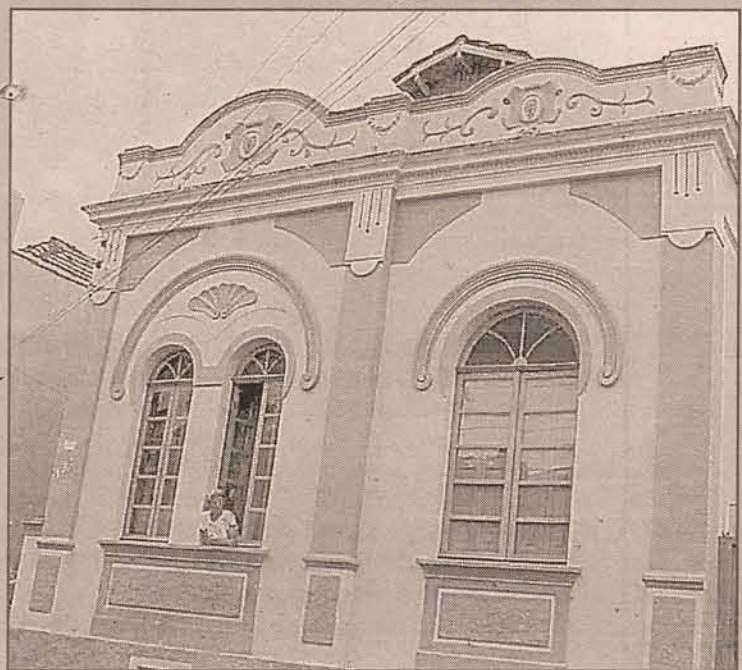
Fachada com dois frontões e platibanda fechada. Exemplo simplificado da arquitetura do estilo art-nouveau. Casa de dona Heralda da Silva, a rua Duque de Caxias.
