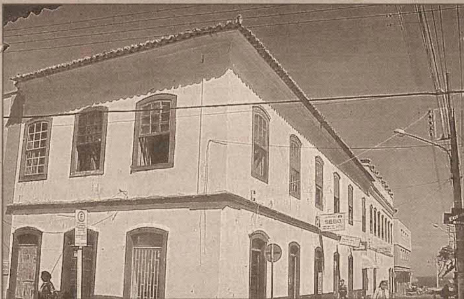
Sobrado luso-brasileiro, austero, isento de decorações, com beiral, cimalha e cunhais fortemente marcados. É o antigo hotel Rio Branco, entre as ruas Gustavo Richard e Barão do Rio Branco.
