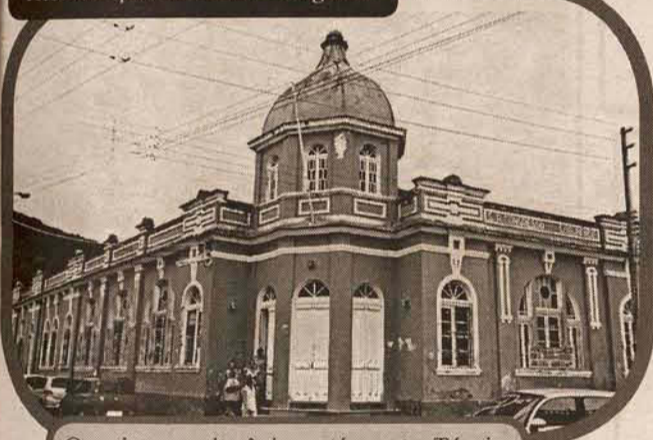
O projeto arquitetônico está pronto. Técnicos da Amurel estão concluindo os projetos complementares do sistema elétrico e hidráulico.
