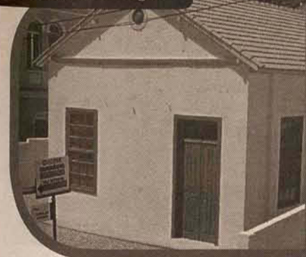
Está sendo elaborado o projeto de ampliação e melhorias do entorno do prédio. História: Antiga estação de energia construída na década de 50. Hoje abriga a Casa do Artesanato, restaurada por uma parceria com o consórcio Camargo Correa/Aterpa/MMartins/Construbase.
