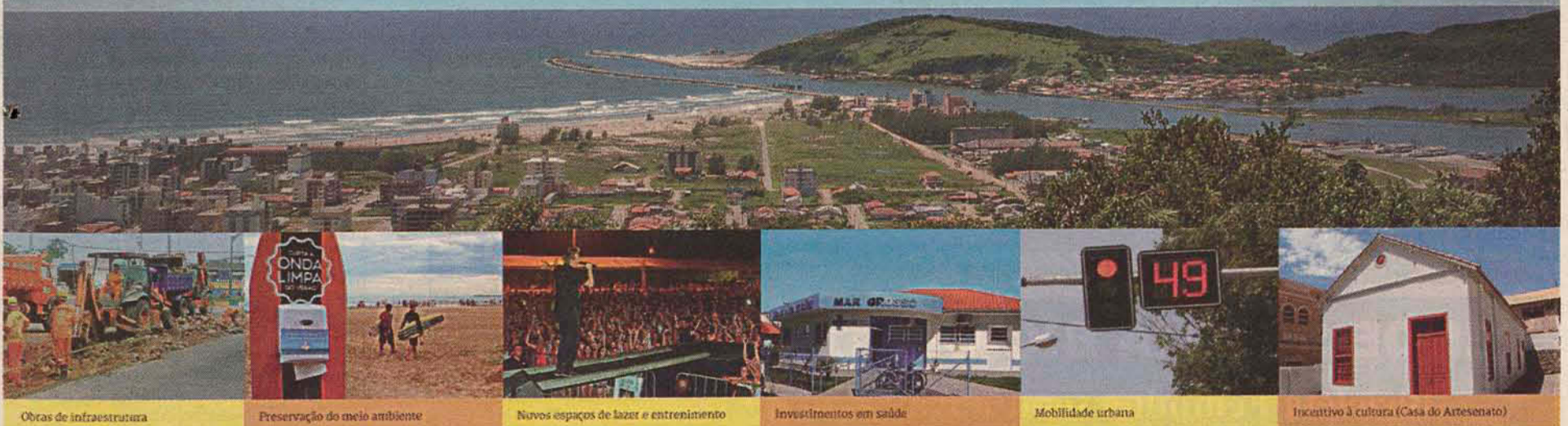
Obras de infraestrutura
