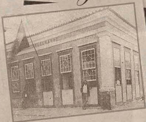
Sede dos Correios e "Telegrapho" entre a praça República Juliana e rua Barão do Rio Branco, em novembro de 1930.
