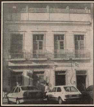
Onde fica a casa Angelita, cujo proprietário recuperou todo o prédio, mantendo as linhas originais.
