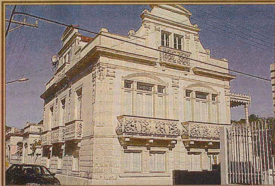
Atual sede da Celesc, ali entre as ruas Duque de Caxias e Tenente Bessa, apresenta arquitetura eclética (já em seu período mais consolidado), caracterizada pelos grandes sobrados, com porão, alto, mais um pavimento e grande uso de ornamentos e detalhes, símbolo de "status". Ela também se destaca pela grande presença de material importado da Europa, como vidros e porcelana.
