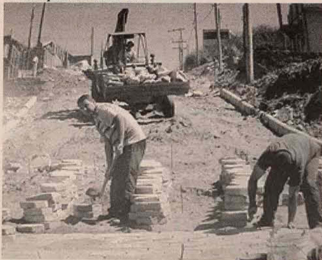
Obra está em bom andamento
