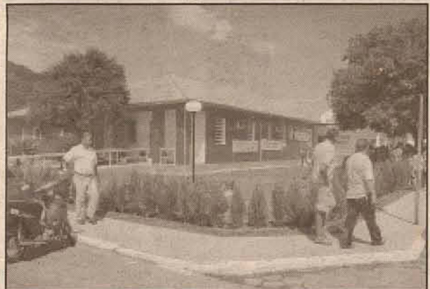
...em construção nova, a moderna Policlínica Dr. Paulo Carneiro.
