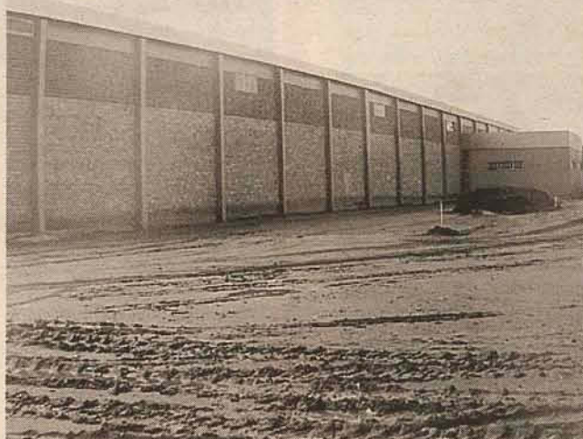
Um perfil da obra em fase de conclusão no Distrito Industrial
