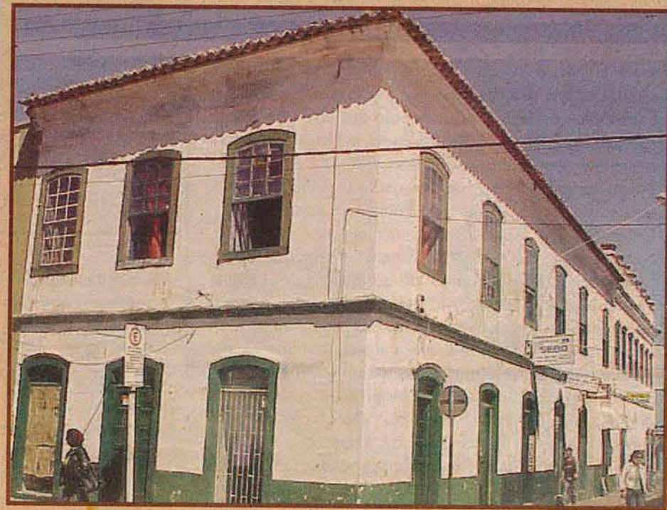
Sobrado luso-brasileiro, austero, isento de decorações, com beiral, cimalha e cunhais fortemente marcados. É o hotel Rio Branco, entre as ruas Gustavo Richard e Barão do Rio Branco.
