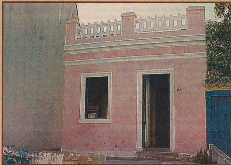
Rua Jerônimo Coelho, 17, centro da cidade, no mesmo alinhamento da Casa de Anita, esta edificação repete também seu sistema construtivo, com alvenarias de pedras e divisórias internas em pau a pique. A fachada não é original, até porque foi alterada para uma arquitetura de característica eclética com platibanda e ornamentos.
