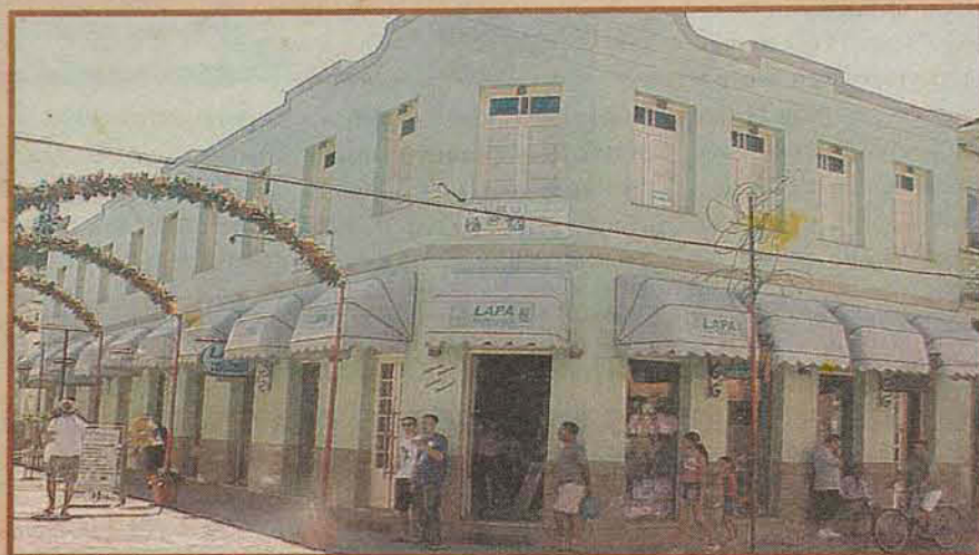
Construção posterior ao período eclético onde a simplicidade do movimento modernista começava a deixar a arquitetura mais pura e sem tantos ornamentos, aqui se vê algumas adaptações decorrentes de uma intervenção recente que buscou manter a marcação do ritmo das aberturas. Localizada entre a rua Raulino Horn e Calçada da XV, no centro da cidade.
