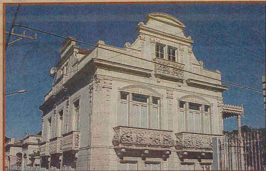
Atual sede da Celesc, ali entre as ruas Duque de Caxias e Tenente Bessa, apresenta arquitetura eclética (já em seu período mais consolidado), caracterizada pelos grandes sobrados, com porão, alto, mais um pavimento e grande uso de ornamentos e detalhes, símbolo de "status". Ela também se destaca pela grande presença de material importado da Europa, como vidros e porcelana.
