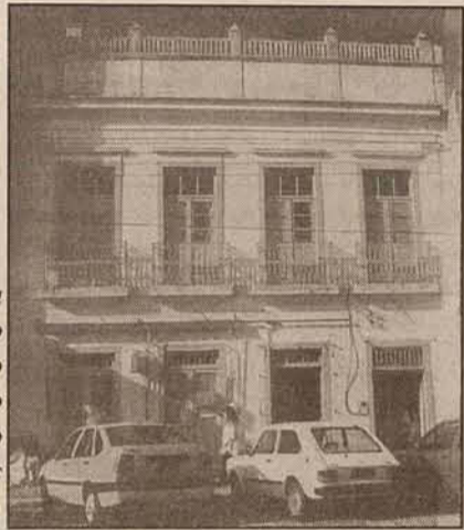
Onde fica a casa Angelita, cujo proprietário recuperou todo o prédio, mantendo as linhas originais.
