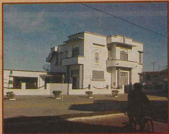
Prédio que abriga a Delegacia da Capitania dos Portos do Estado de Santa Catarina, em Laguna. Recuperado, mantém as linhas originais. Faz parte do centro histórico da cidade.
